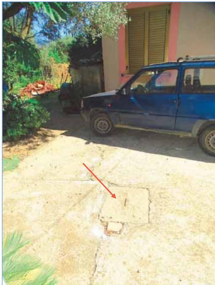
FOTO 8 – Pozzetto fossa biologica posto nel suolo proprietà Carà A. M. part. 1636, dove scarica la fogna dell'abitazione.
