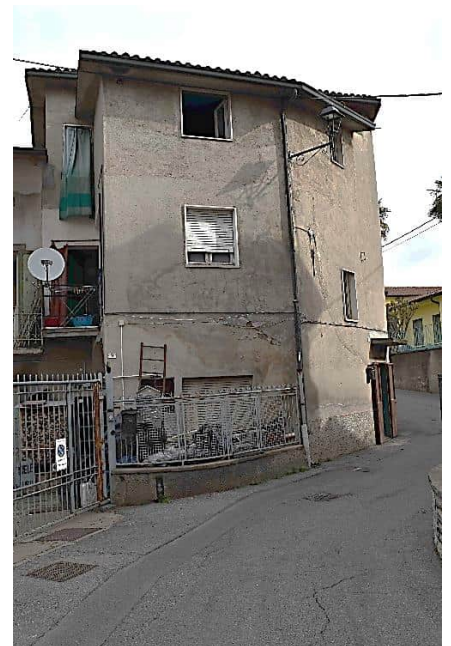
Vista Sud fabbricato cielo/terra.
