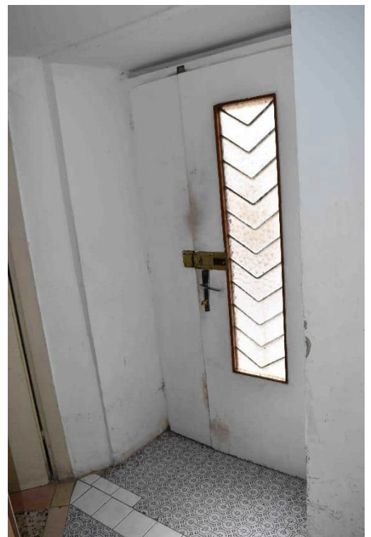
Vista interna dell'ingresso.
