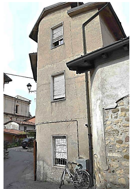
Vista Est fabbricato cielo/terra.
