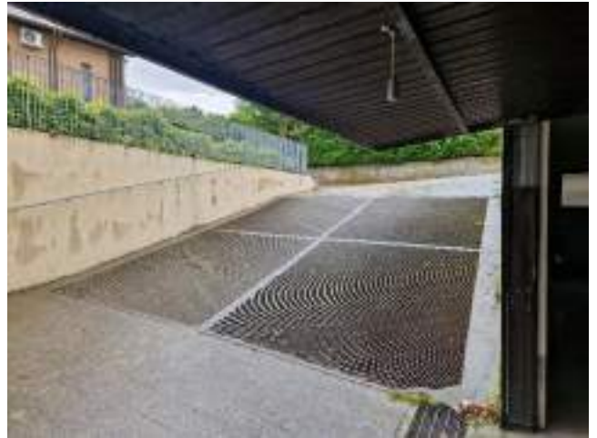
foto n. 14 - rampa di accesso al piano interrato
