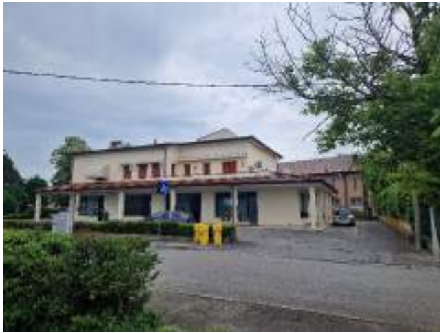
foto n. 1 – fronte sud del condominio
