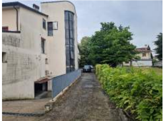
foto n. 16 - area scoperta - porzione nord
