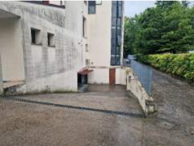
foto n. 15 - rampa accesso ai garages e cantine
