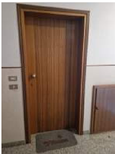
foto n. 5 – portoncino di ingresso
