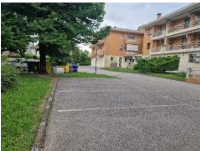
foto n. 17 - posti auto area scoperta
