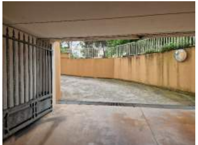
foto n. 16 - rampa di accesso ai garages
