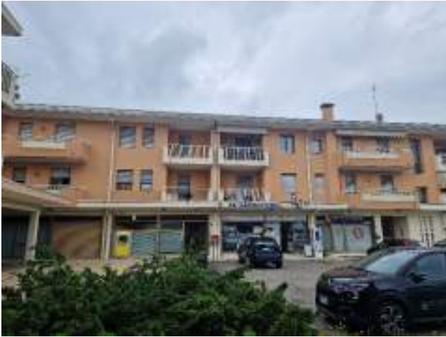
foto n. 1 – fronte ovest del condominio
