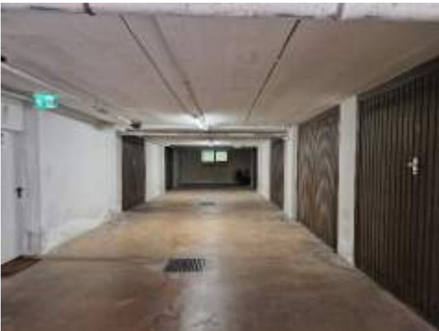
foto n. 15 - corsia di manovra
