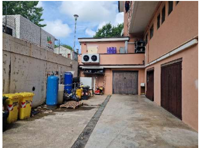
foto n. 14 – rampa di accesso ai garages
