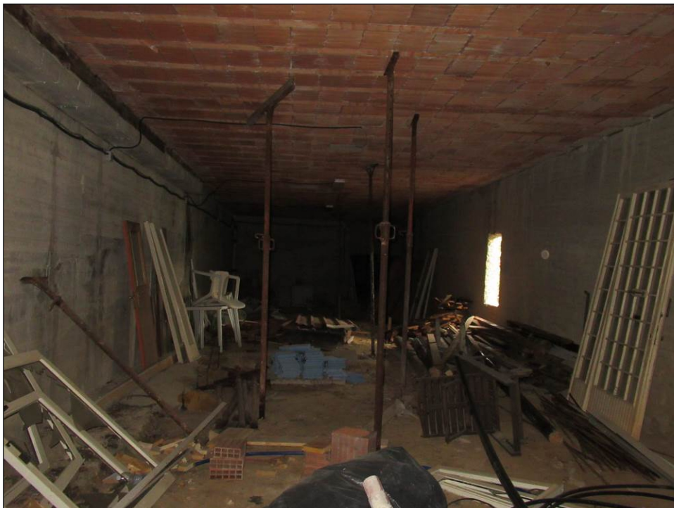
Foto 56 – vista locali seminterrati
