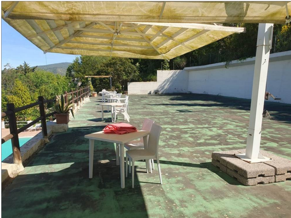
Foto 13 – Vista terrazzo sopra piscina
