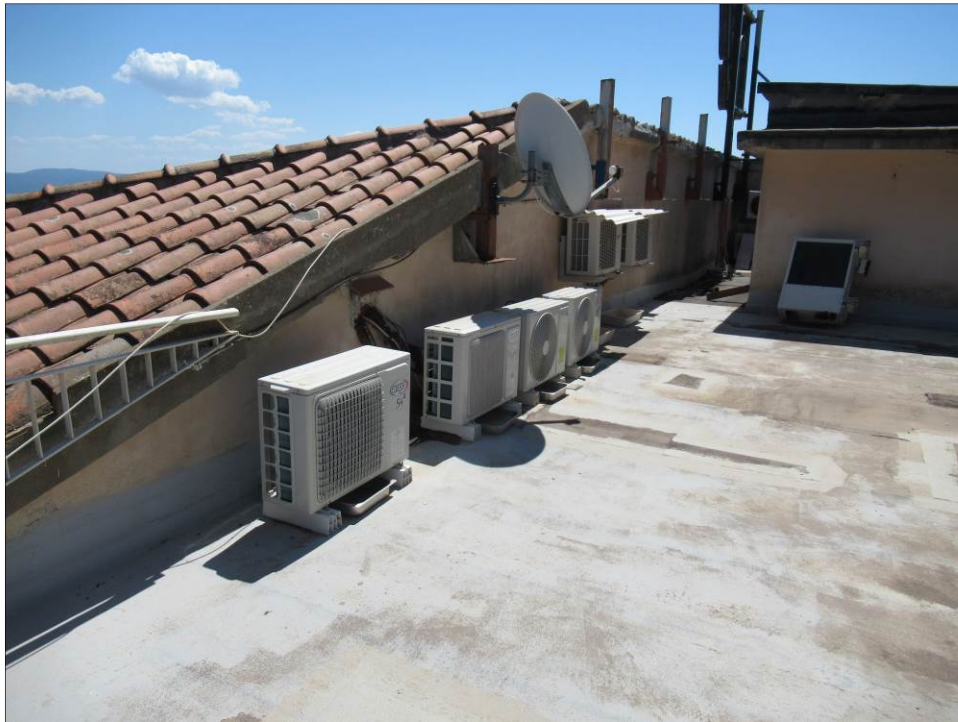
Foto 51 – vista lastrico solare - copertura
