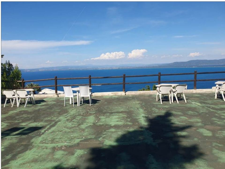
Foto 14 – Vista terrazzo sopra piscina
