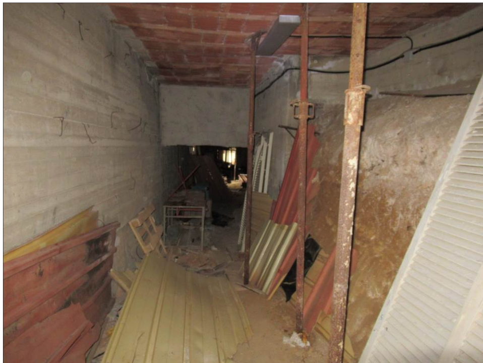
Foto 58 – vista locali seminterrati
