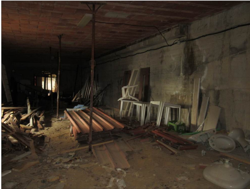
Foto 57 – vista locali seminterrati
