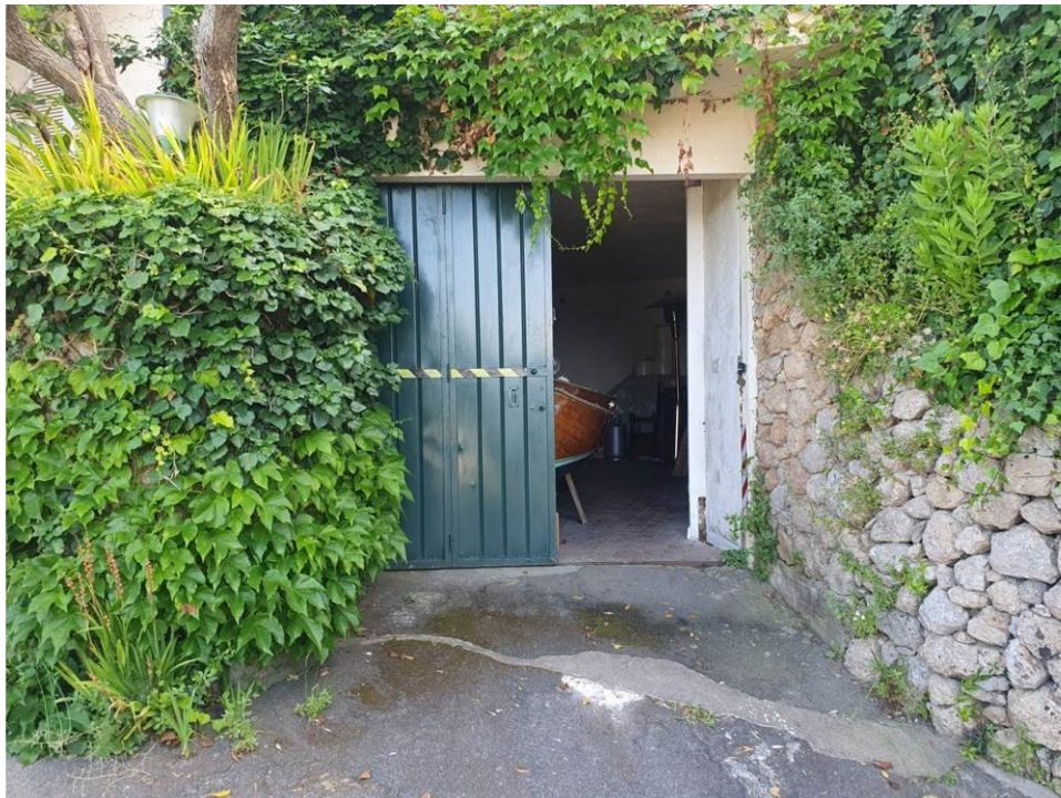
Foto 59 – ingresso magazzino ( magazzino accessibile da parcheggio )
