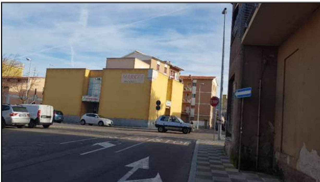
Foto 1 – prospetto lato Nord
