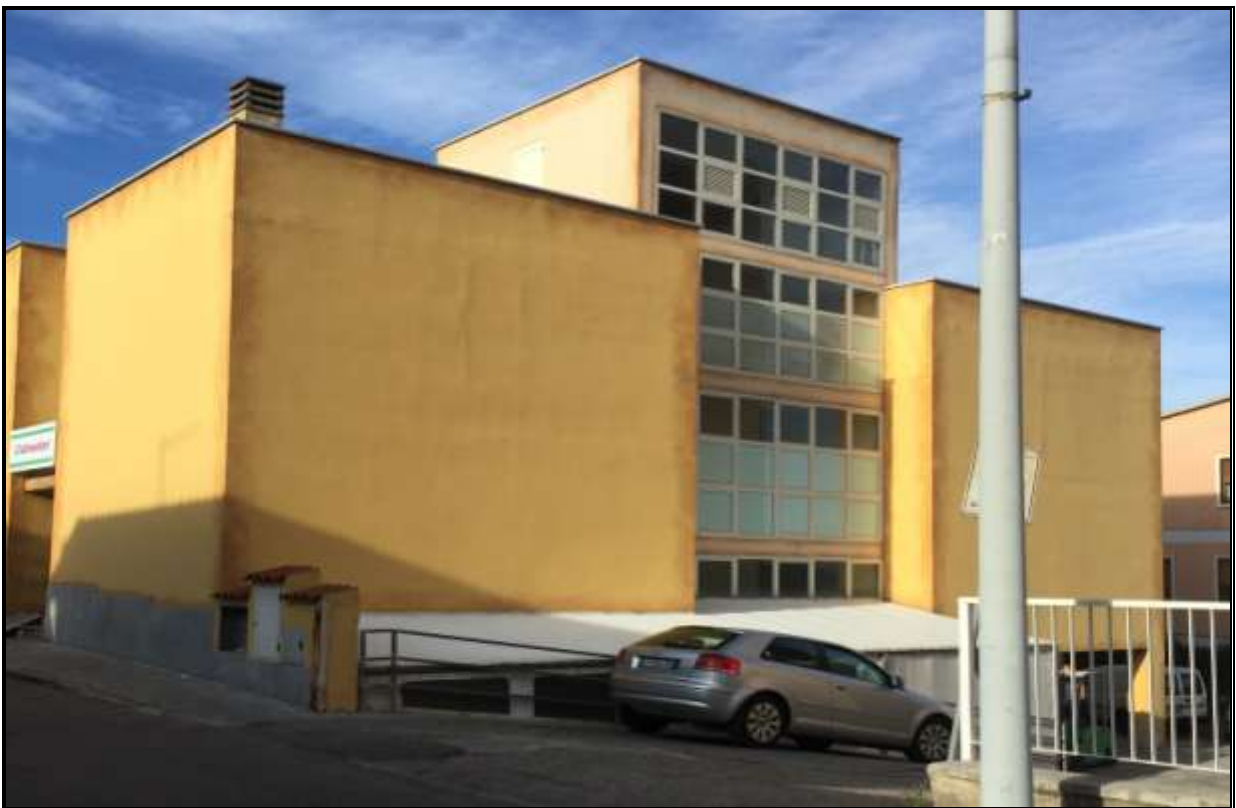
Foto 3 – prospetto lato Sud
