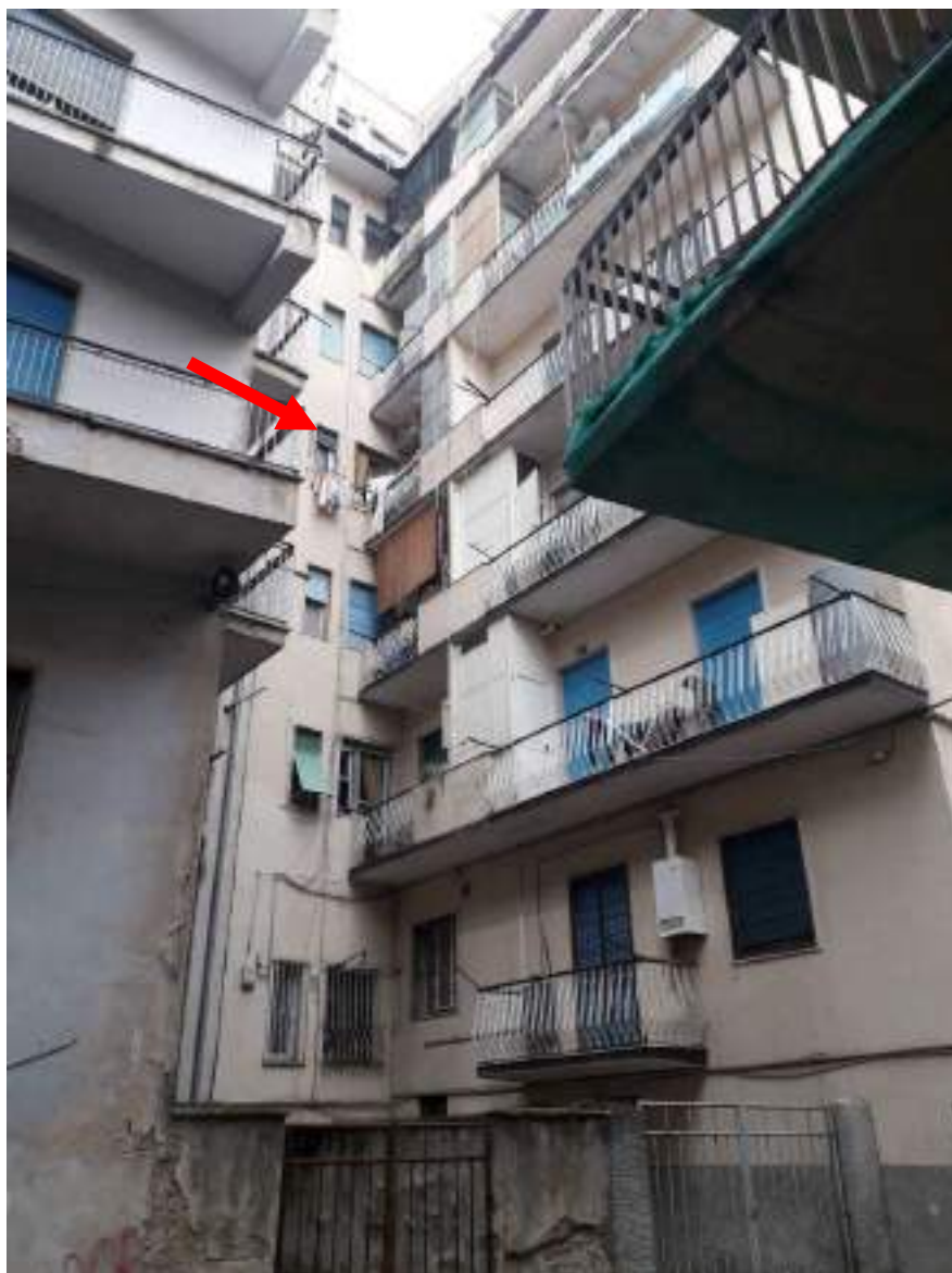
Foto N.4: Prospetto fabbricato Sud
