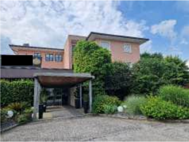
foto n. 1 – fronte nord del condominio
