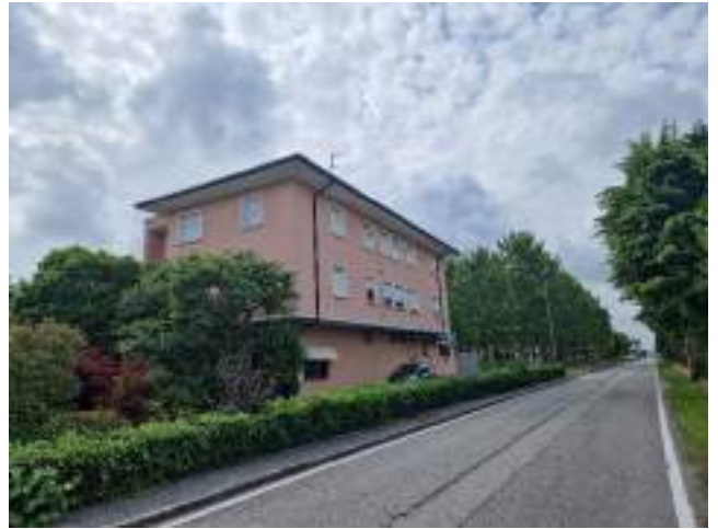
foto n. 2 – fronte ovest del condominio
