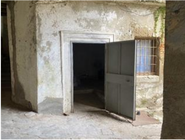
Ingresso al deposito piano terra
