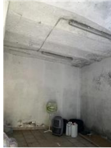
Interno deposito piano terra
