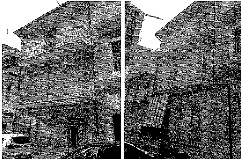
FOTO 1 e 2 – Facciata nord-ovest e facciata sud-est dell'abitazione in Cutro Trav. San Rocco n. 21.
