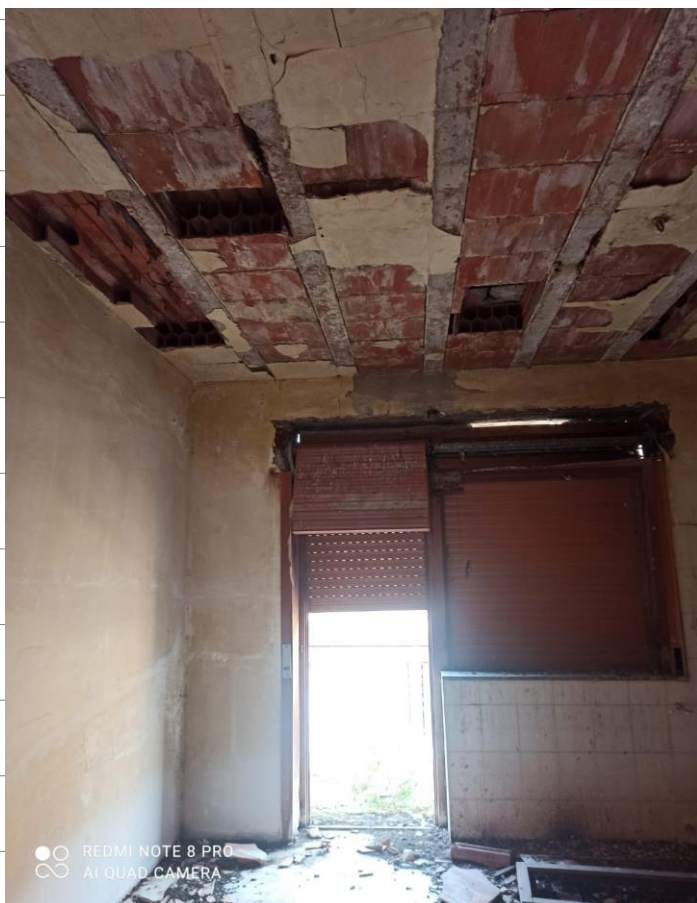
Foto 2 particolare intradosso solaio e serramenti appartamenti 4° piano
