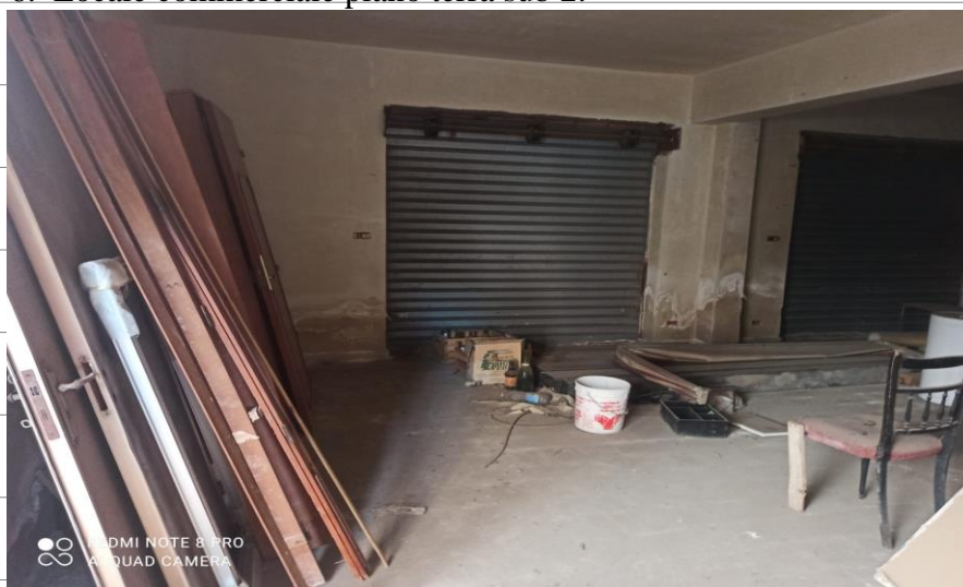
Foto 6. Locale commerciale piano terra sub 2.
