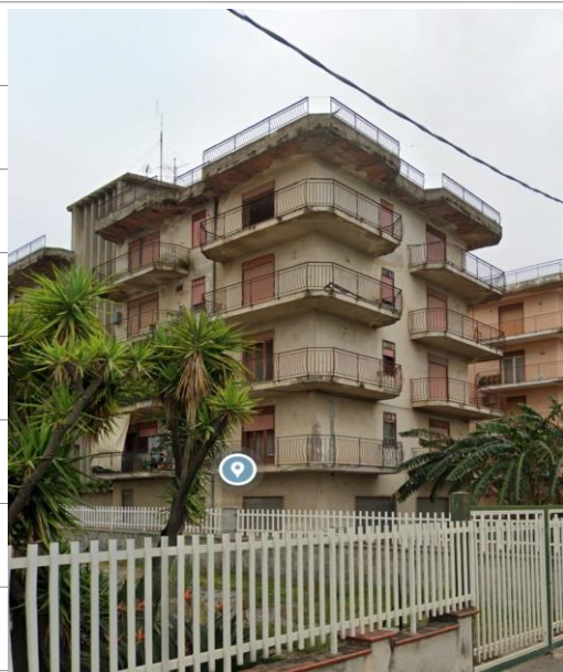
Figura 7 – la palazzina vista da via Oreto - prospetti sud est – sud ovest
