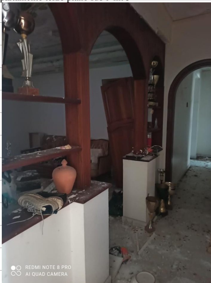
Foto 7. Appartamento terzo piano sub 9 int 5
