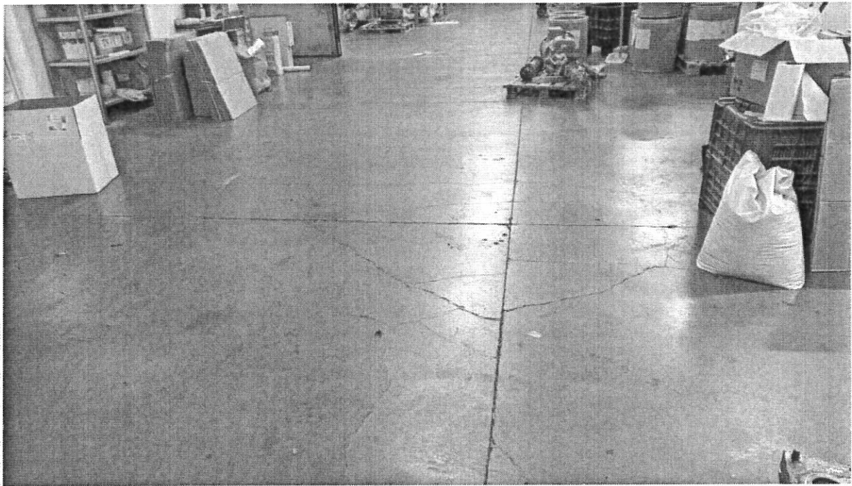
Figura 18. Opificio, interni. Particolare della pavimentazione.
