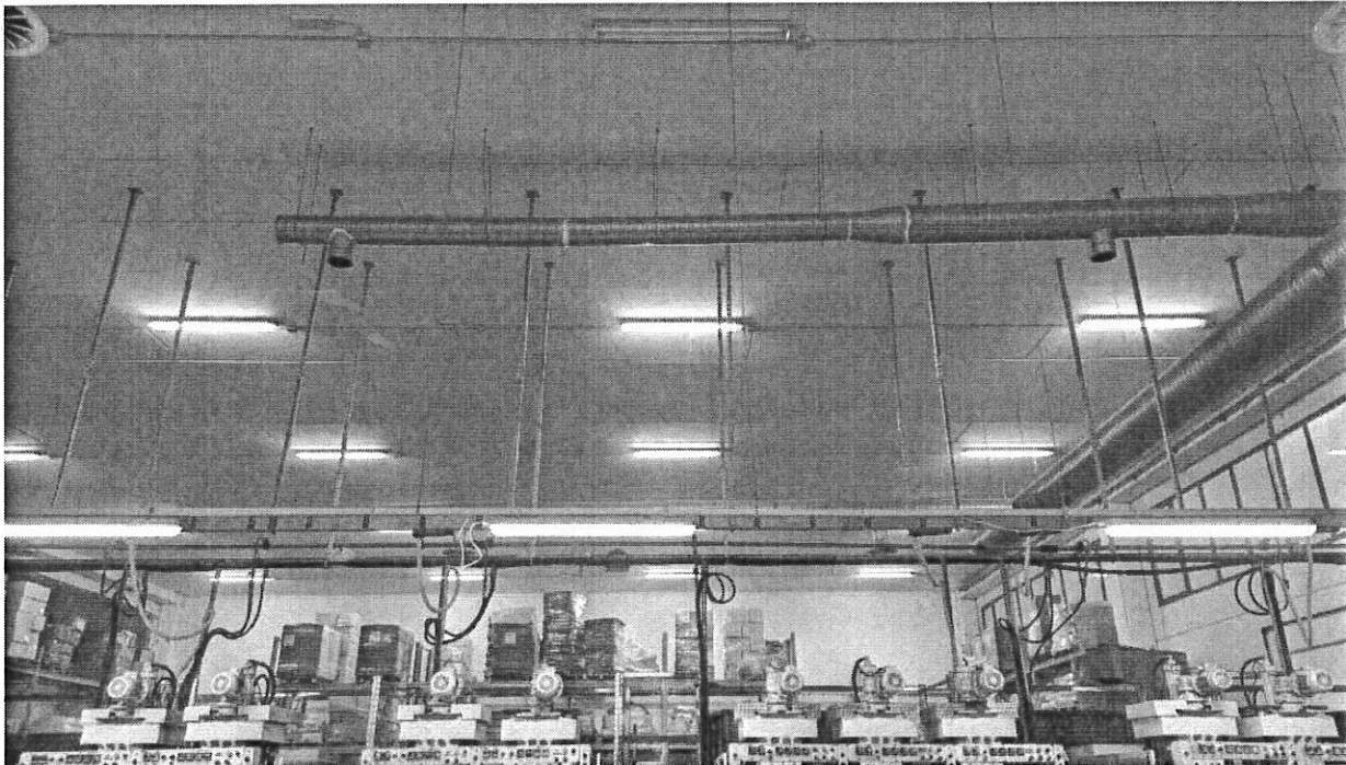
Figura 19. Opificio, interni. Particolare del soffitto e dell'impianto di illuminazione.
