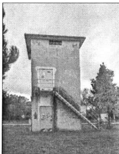
Figura 4: foto da operazioni peritali - cabina elettrica
