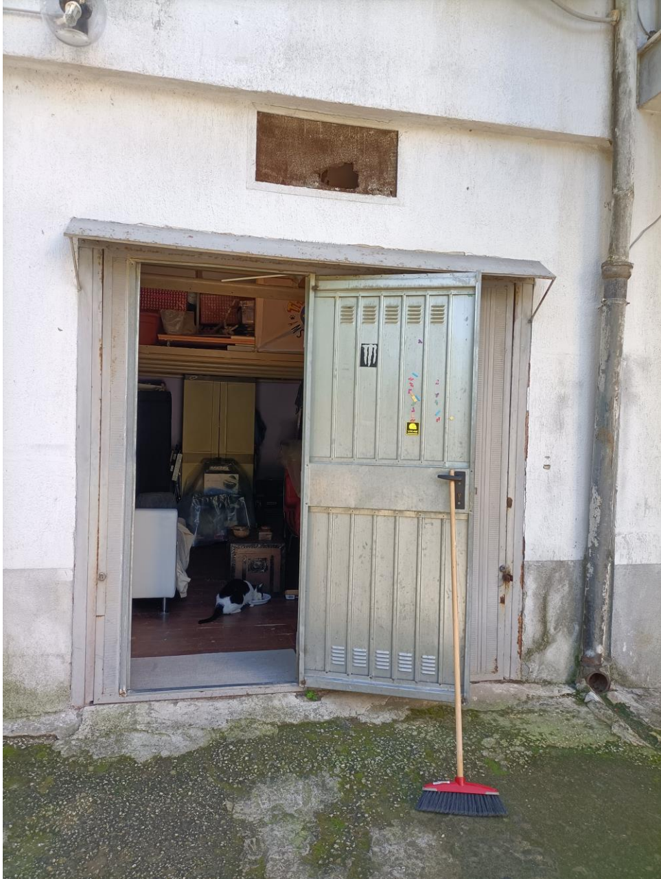
Foto 14. Vista esterna del garage.
