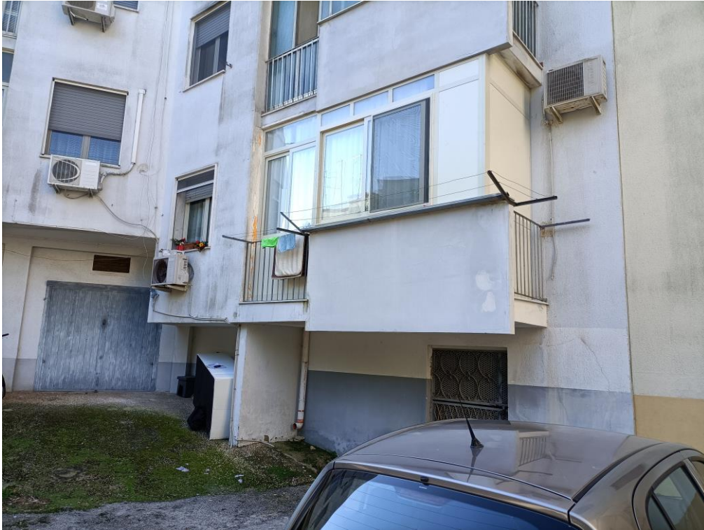
Foto 2. Vista esterna dell'unità immobiliare oggetto di stima posta al piano rialzato – lato nord-est.
