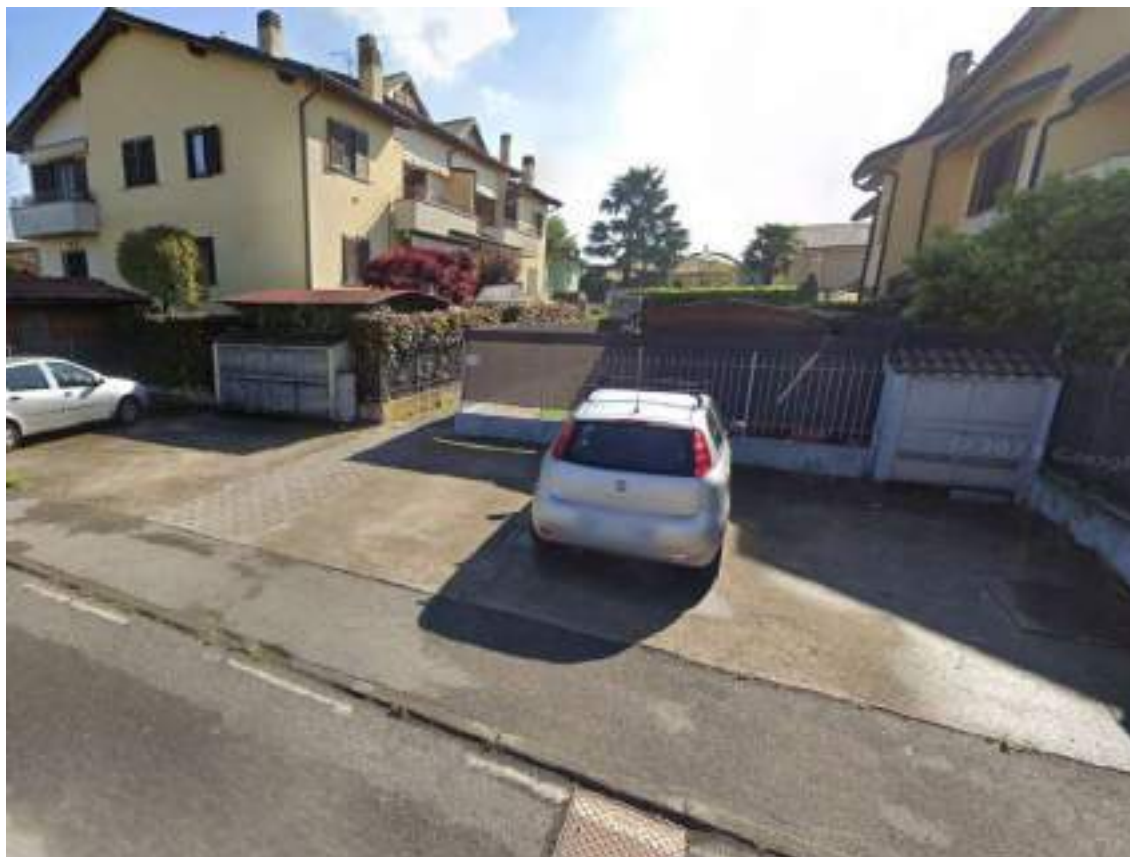
Foto n. 3 | Vista generale dell'edificio da via Brusocchi.
