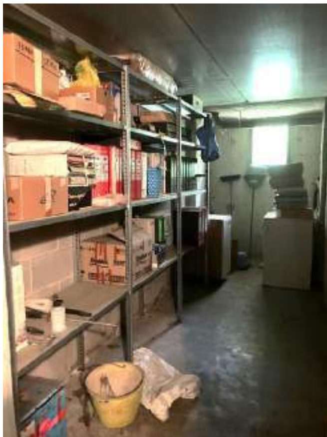
Foto n. 27 | Vista della cantina.
