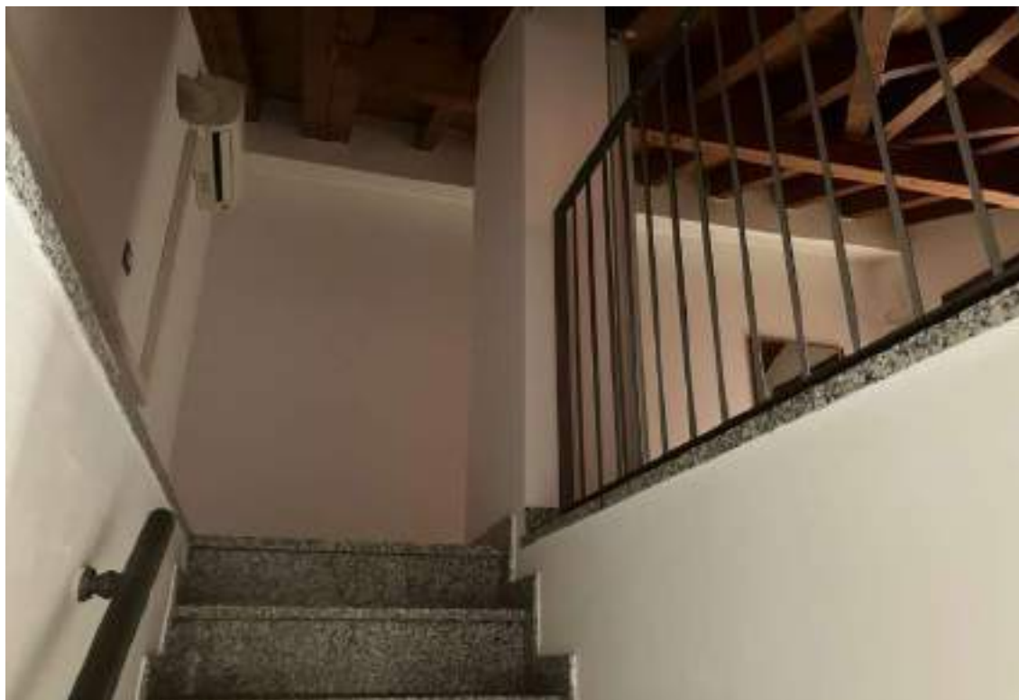
Foto n. 21 | Vista della scala che sale al piano mansardato.
