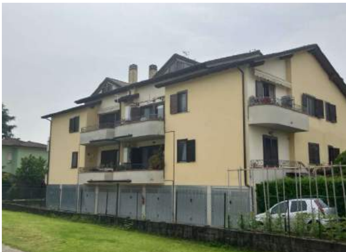
Foto n. 7 | Vista della facciata posteriore del condominio.
