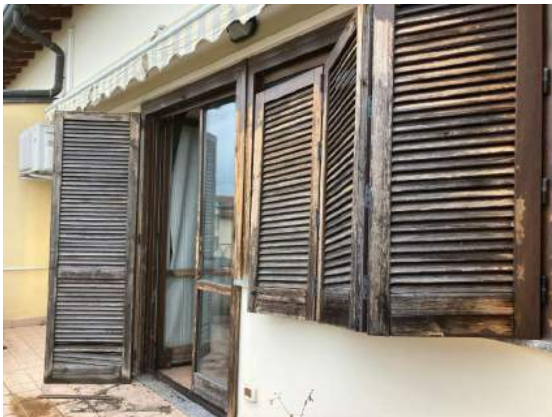
Foto n. 20 | Vista dei serramenti del soggiorno.
