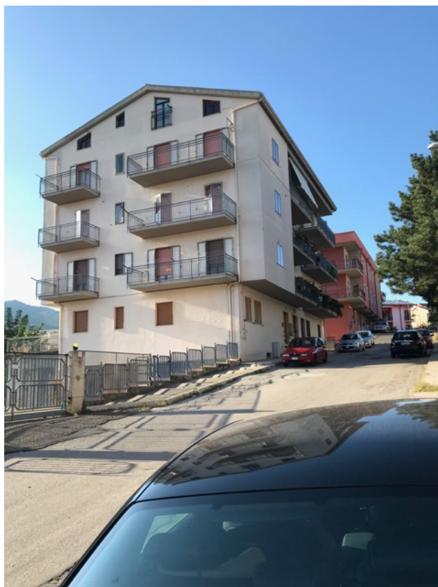
foto n. 1 – Esterno fabbricato da via Rossini
