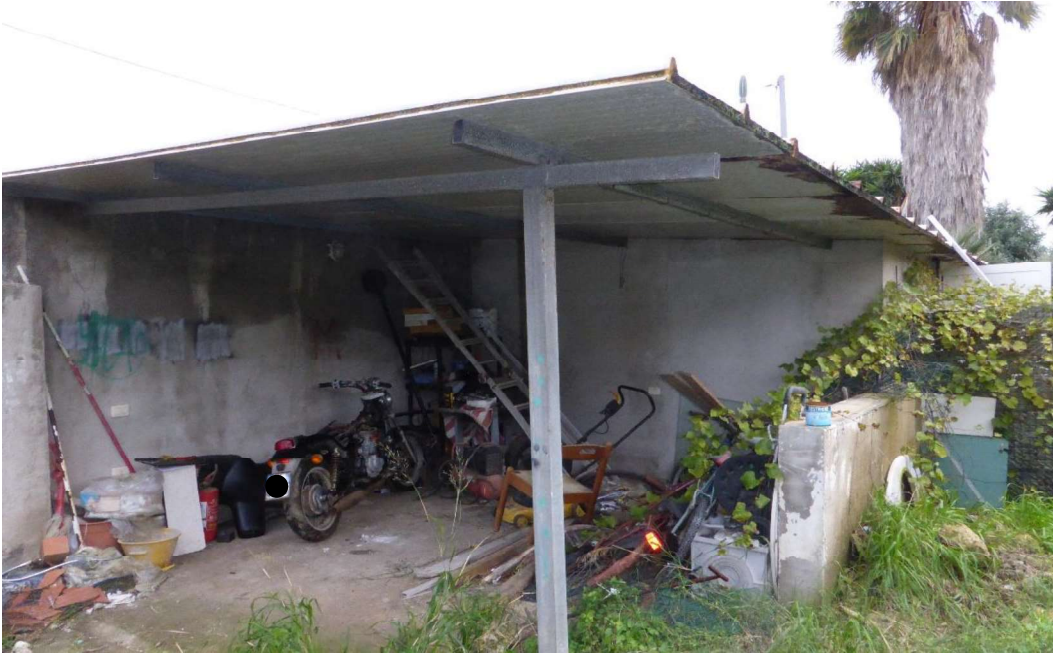
Fotografia n° 21 Tettoia sul confine anteriore
