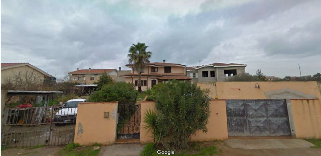
Fotografia n° 1 Accesso da strada rurale
