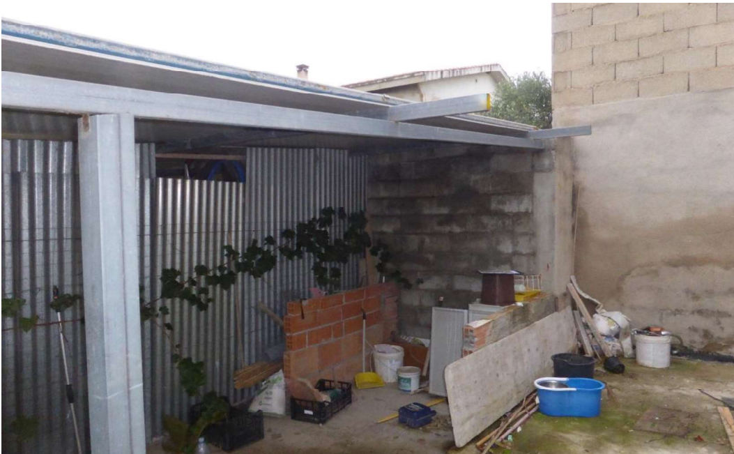
Fotografia n° 22 Tettoia sul confine posteriore
