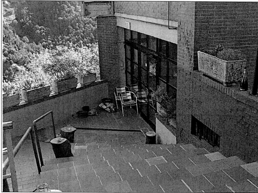
Foto 9: da piano T, bene B1, verso ingresso bene B2 al piano S1
