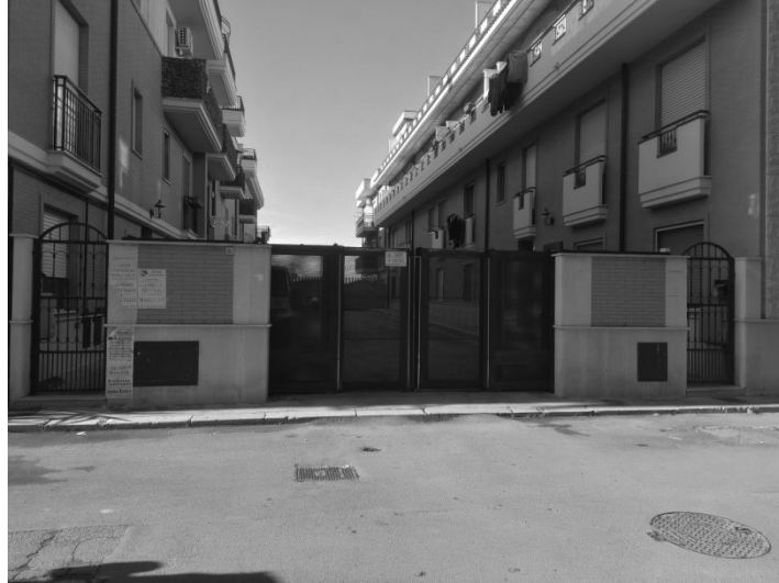
Accesso al cortile condominiale
