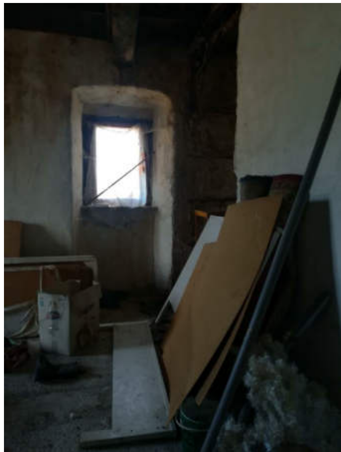
Foto 25, 26 e 27 – Vista interna appartamento, piano primo (sottotetto)
