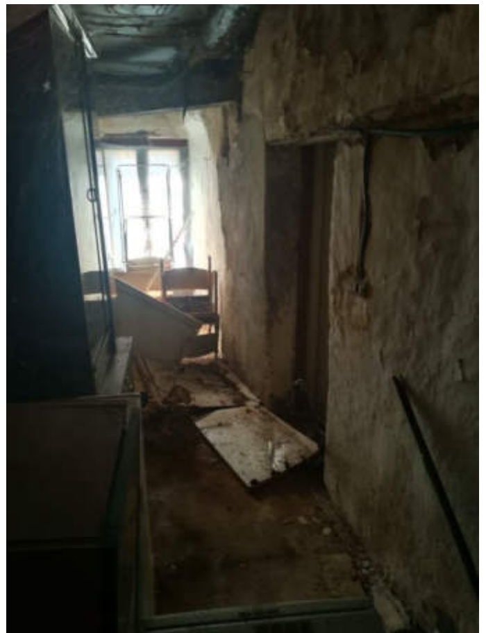
Foto 15 – Vista interna rip./cantina, piano terra
