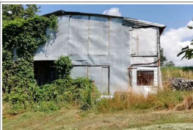
Annesso – vista da sud
