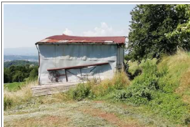
Annesso – vista da est
