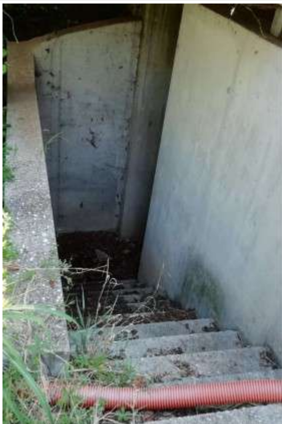
Accesso vasca antincendio
