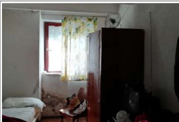
Interno piano terra foto 3
