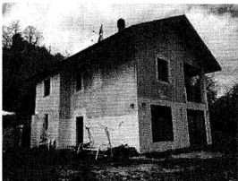
Foto 2: Vista d'insieme fabbricato
