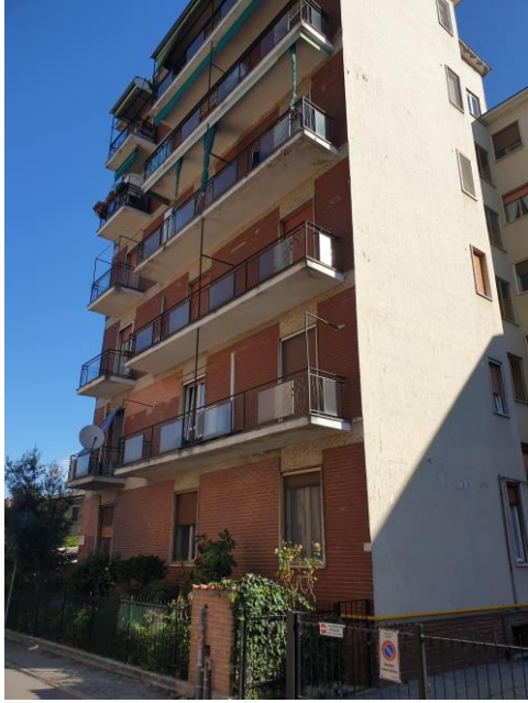
Foto 1: Individuazione ingresso – lato frontale
