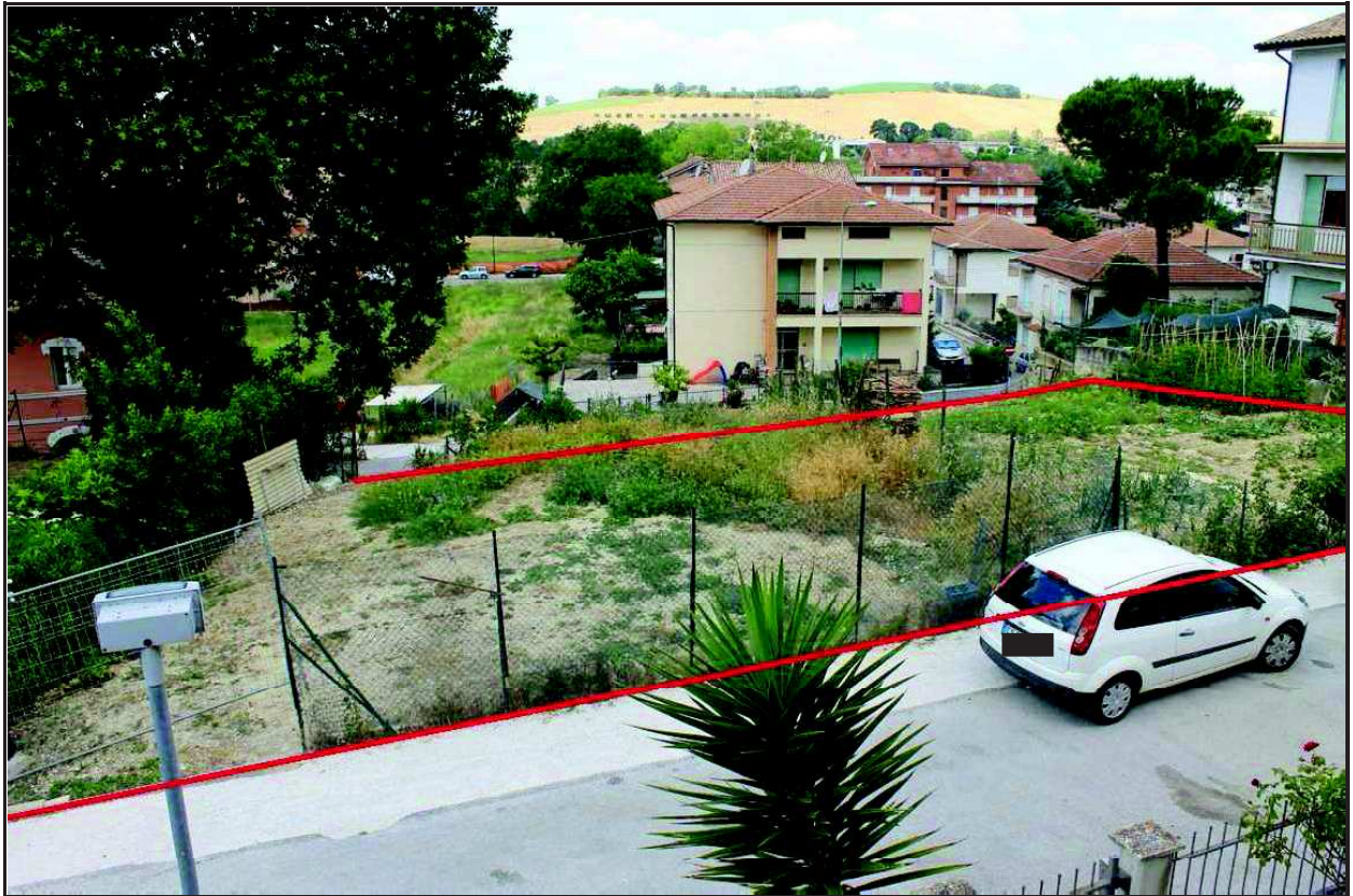
FOTO 1: Vista fronte est
