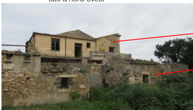
lato a sud-ovest
