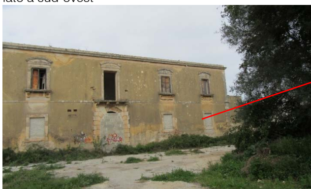
lato a sud-est
