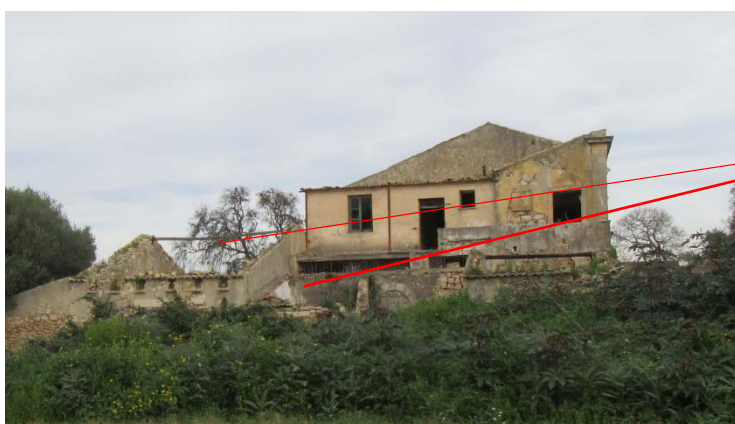
lato a sud-ovest
