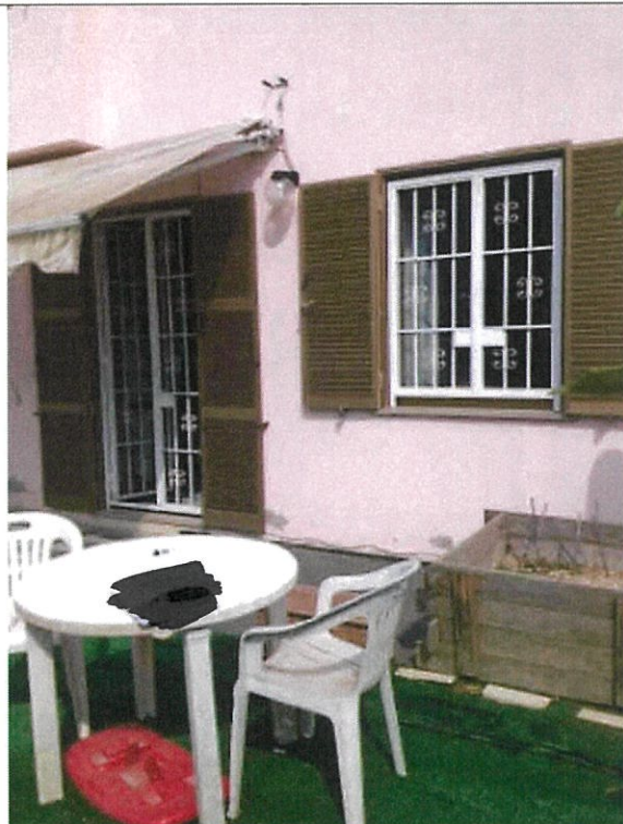
Terrazzo sul retrospetto – piano terra
