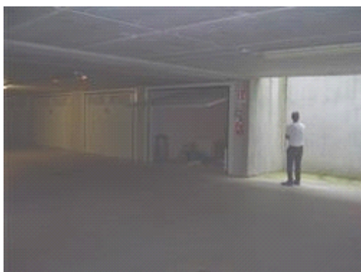
vista dall'ingresso corsello
