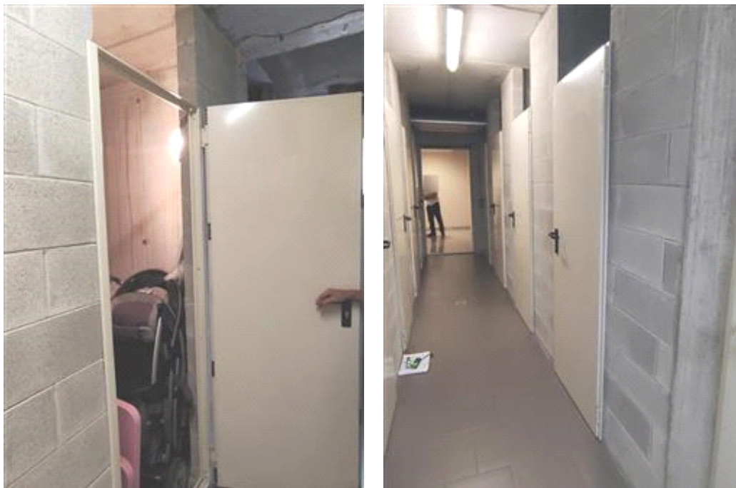
disimpegno comune zona cantine
