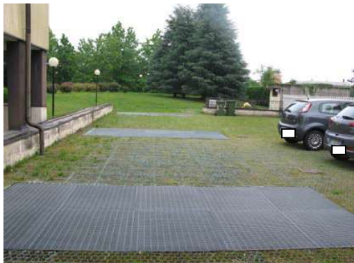
Foto 3 – Esterno – passaggio comune
