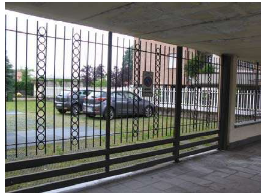
Foto 2 – Esterno – cancello di ingresso
