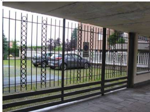
Foto 2 – Esterno – cancello di ingresso
