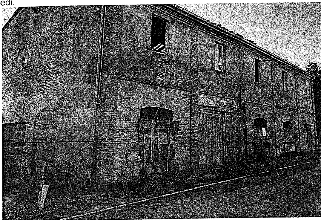
Foto facciata su strada
