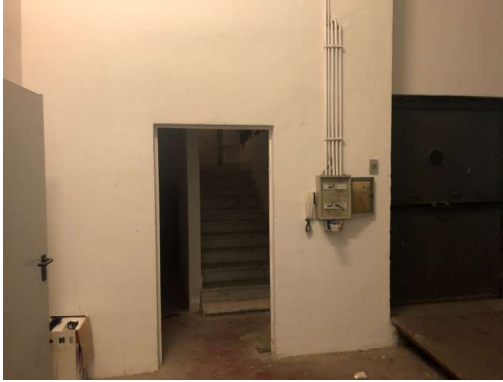
Gradinata interna e montacarichi
