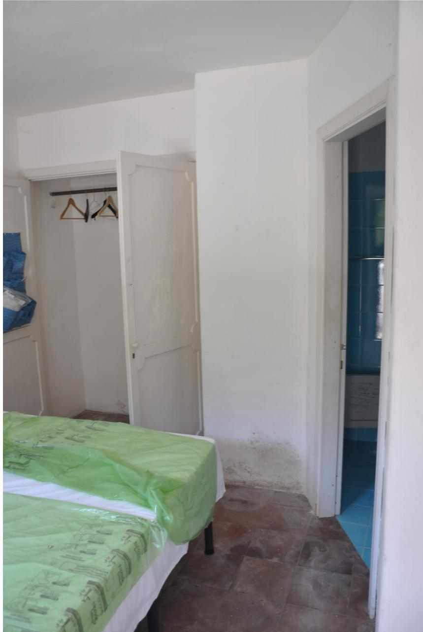
Particolare delle macchie di umidità alla base delle pareti della camera più piccola
