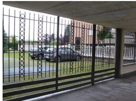
Foto 2 – Esterno – cancello di ingresso
