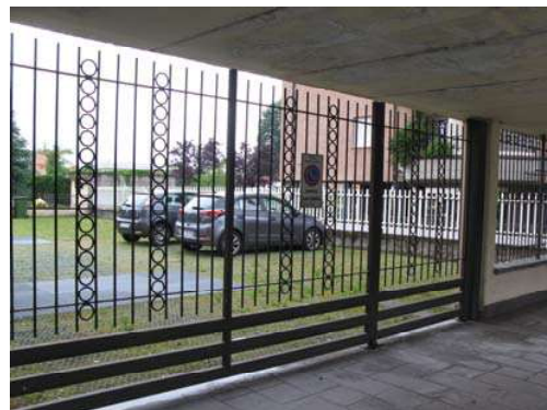
Foto 2 – Esterno – cancello di ingresso
