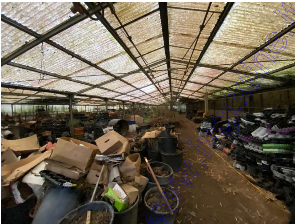
Foto 5 – vista interna capannone
