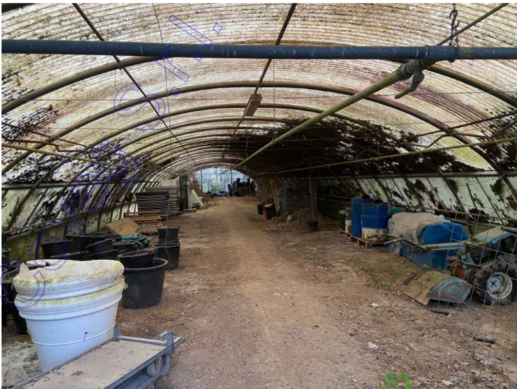
Foto 9 – vista interna capannone
