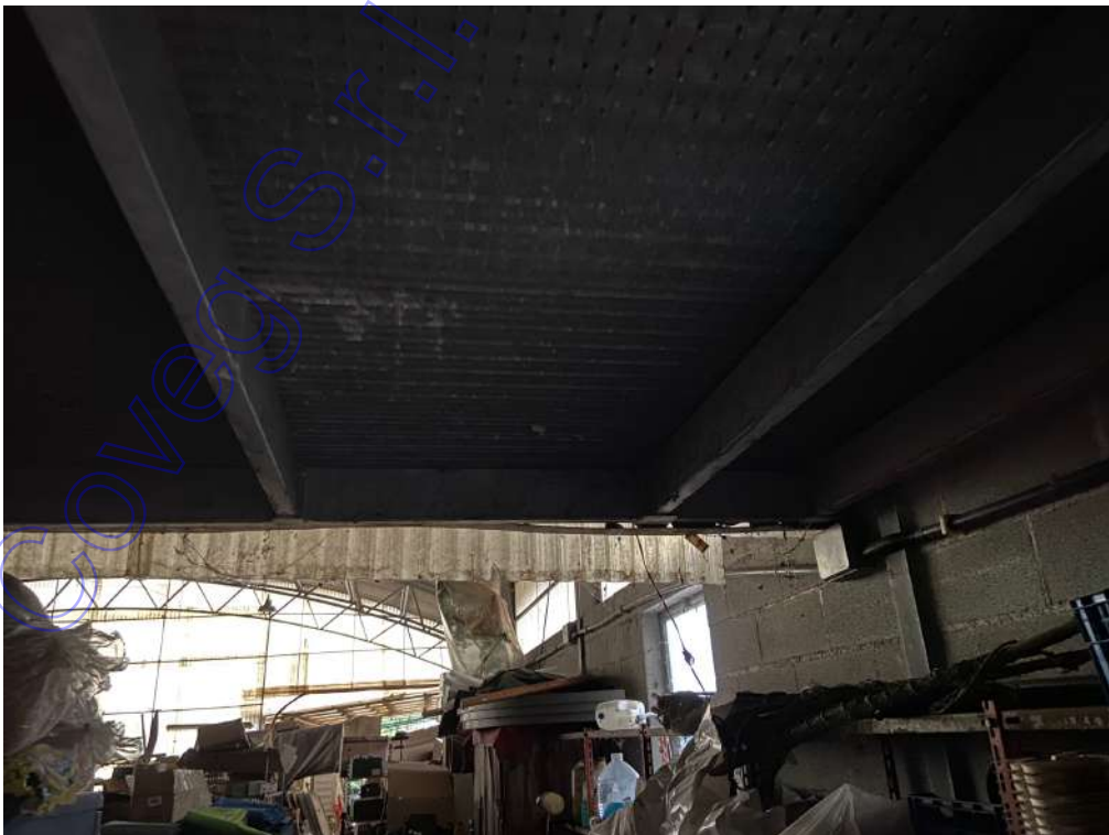
Foto 7 – vista interna capannone
