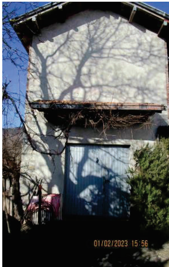
Deposito e cassero legnaia
