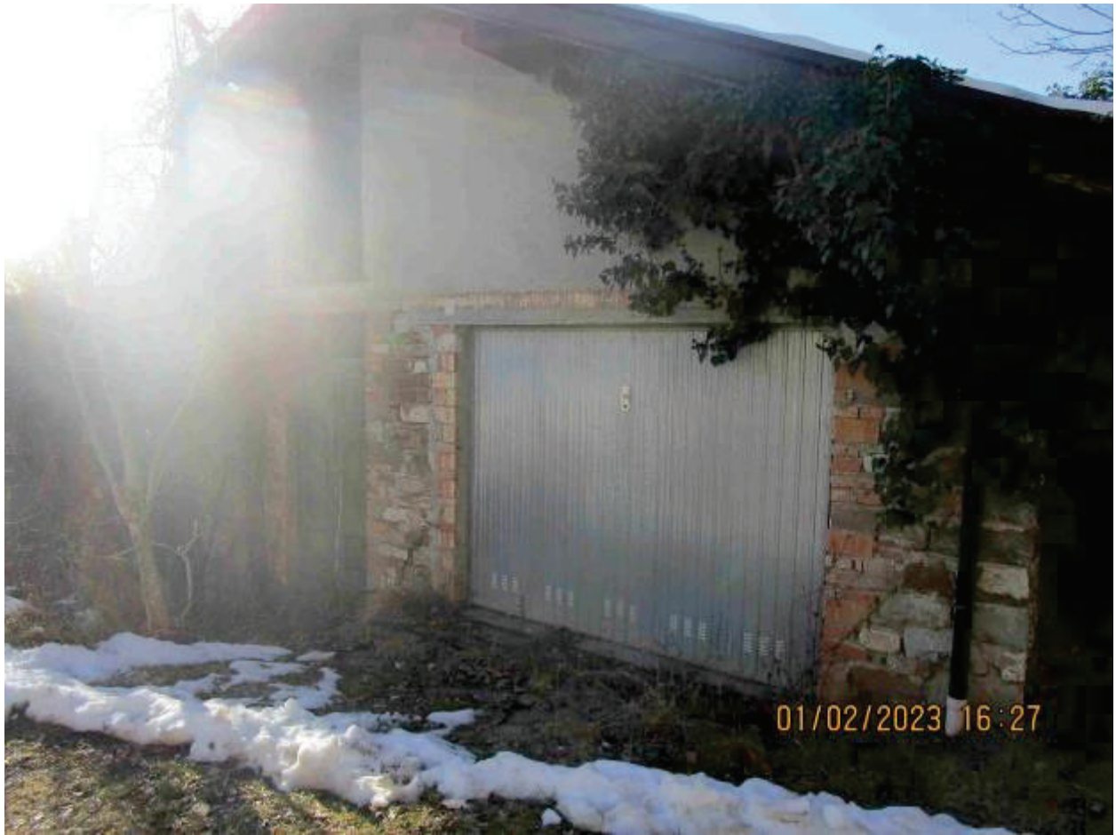
Autorimessa mappale 558 sub. 3
