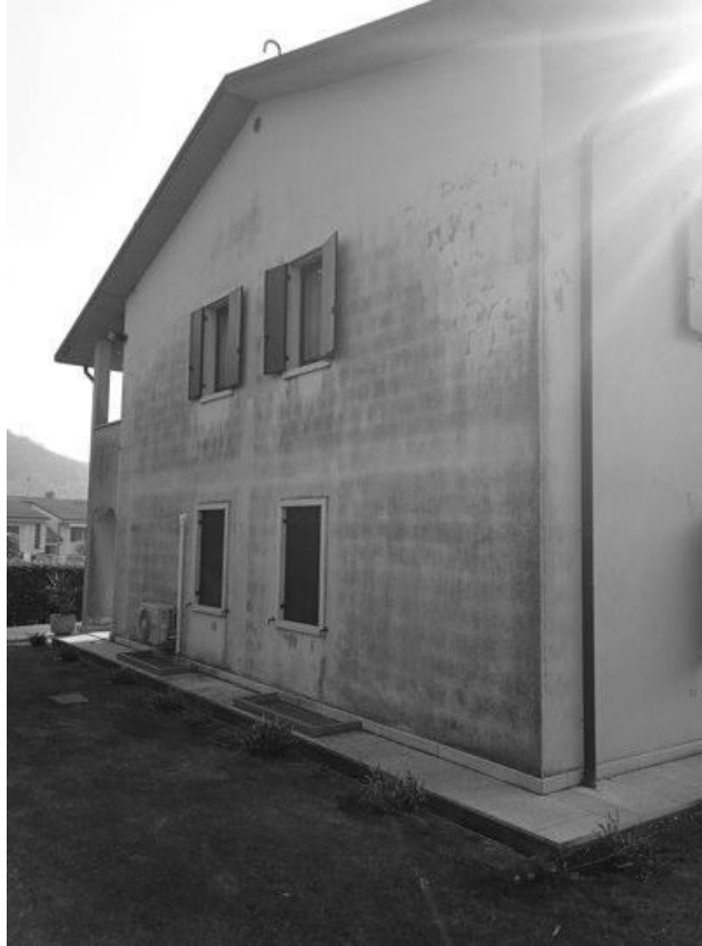
dettaglio del prospetto nord del bene pignorato
