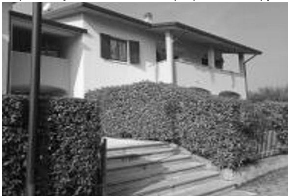
scala pedonale di ingresso comune al fabbricato B/1. Al piano primo si trova il bene pignorato
