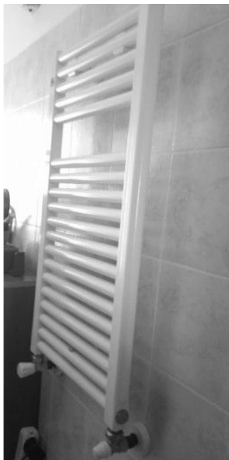
corpi scaldanti tubolari in alluminio nel bagno
