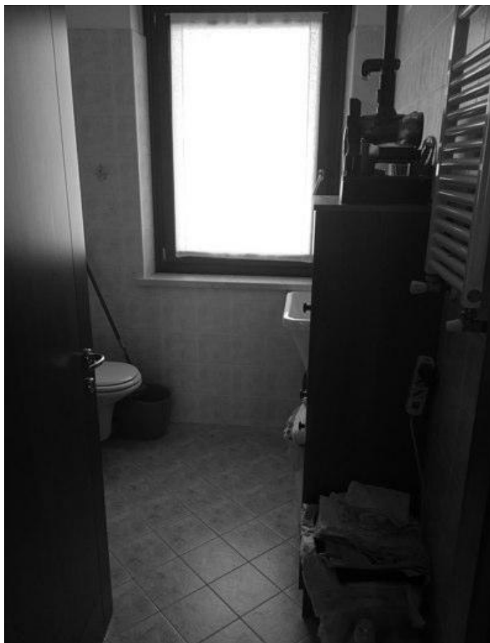
dettaglio dei bagni del bene pignorato al piano primo
