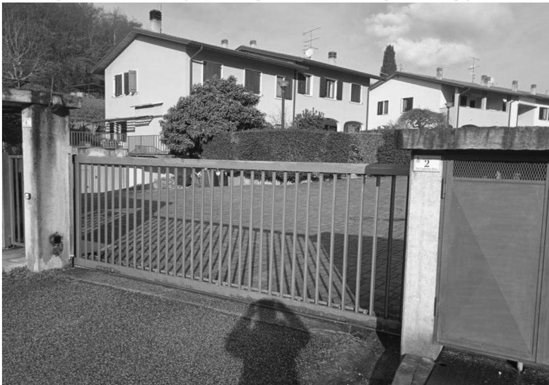
cancello pedonale e carraio di ingresso al complesso edilizio di cui fa parte il bene pignorato
