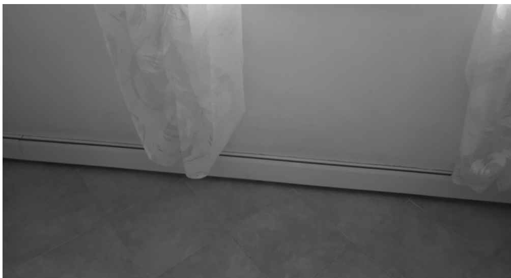
riscaldamento a battiscopa radiante in alluminio
