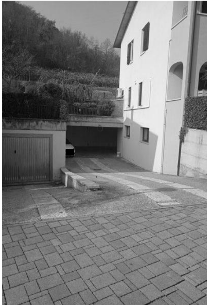
dettaglio rampa di accesso ai garage interrati del bene pignorato
