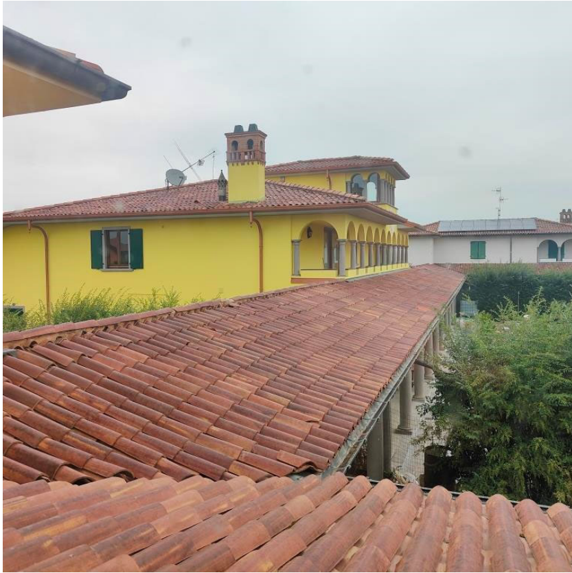
Fotografia 15 – vista della copertura del porticato
