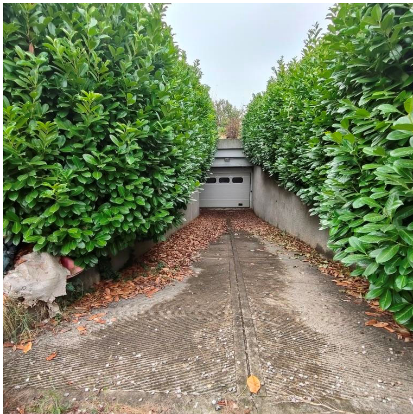
Fotografia 26 – rampa di accesso ad autorimessa
