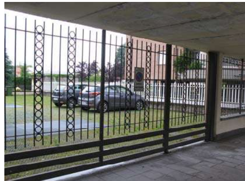
Foto 2 – Esterno – cancello di ingresso
