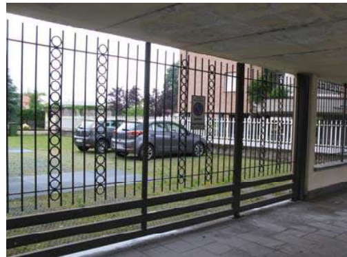
Foto 2 – Esterno – cancello di ingresso
