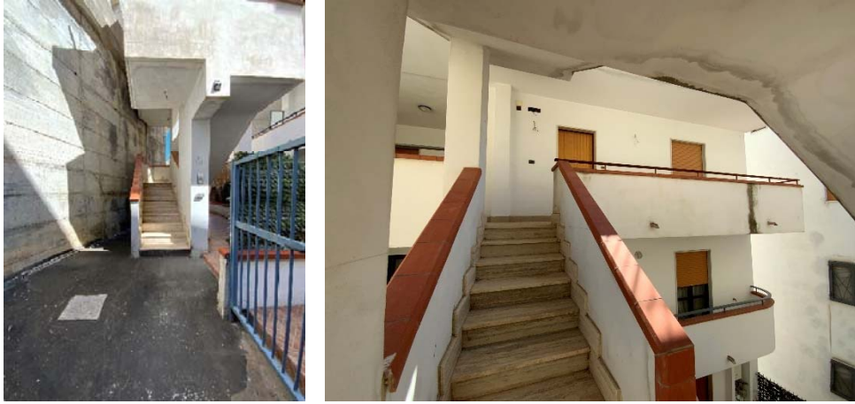
Particolare accesso all'immobile, scala sub.12
