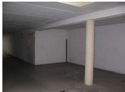
Foto 4 – Interno – Posto auto PS1
