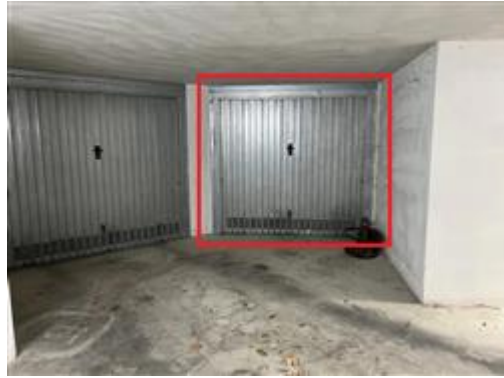
Basculante ingresso garage
