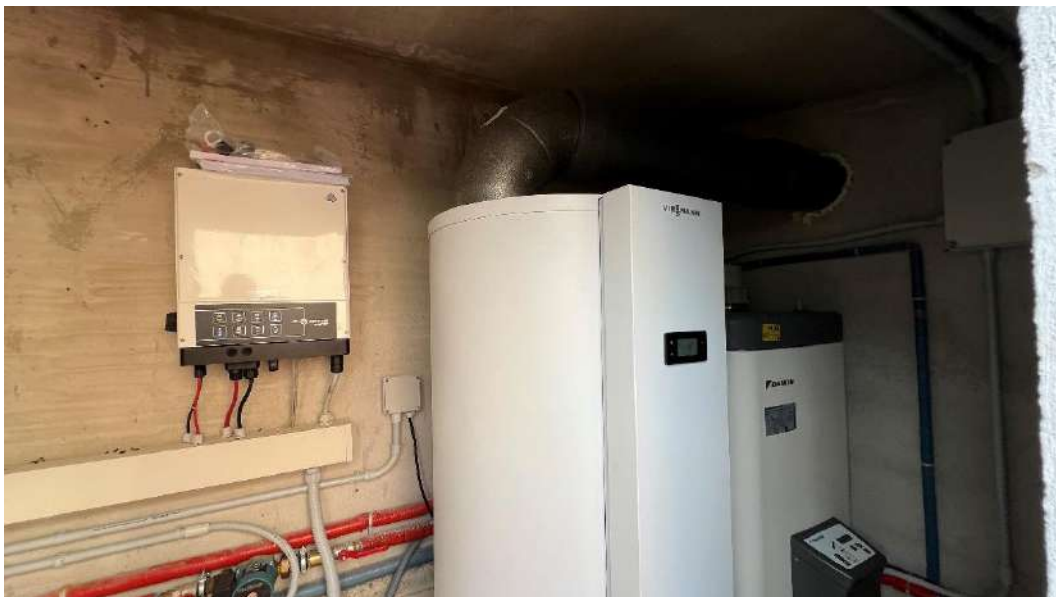
Figura 6 – Viste dei volumi realizzati sulla terrazza Ovest in disaccordo con il progetto approvato
