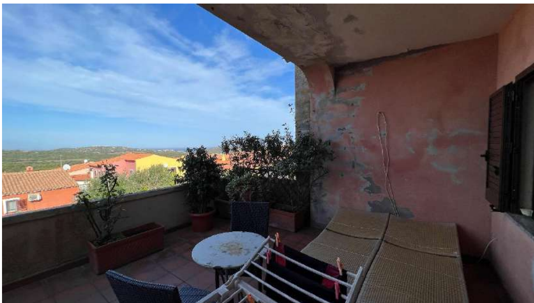
Figura 3 – Viste della Veranda e della Terrazza esposte a Nord
