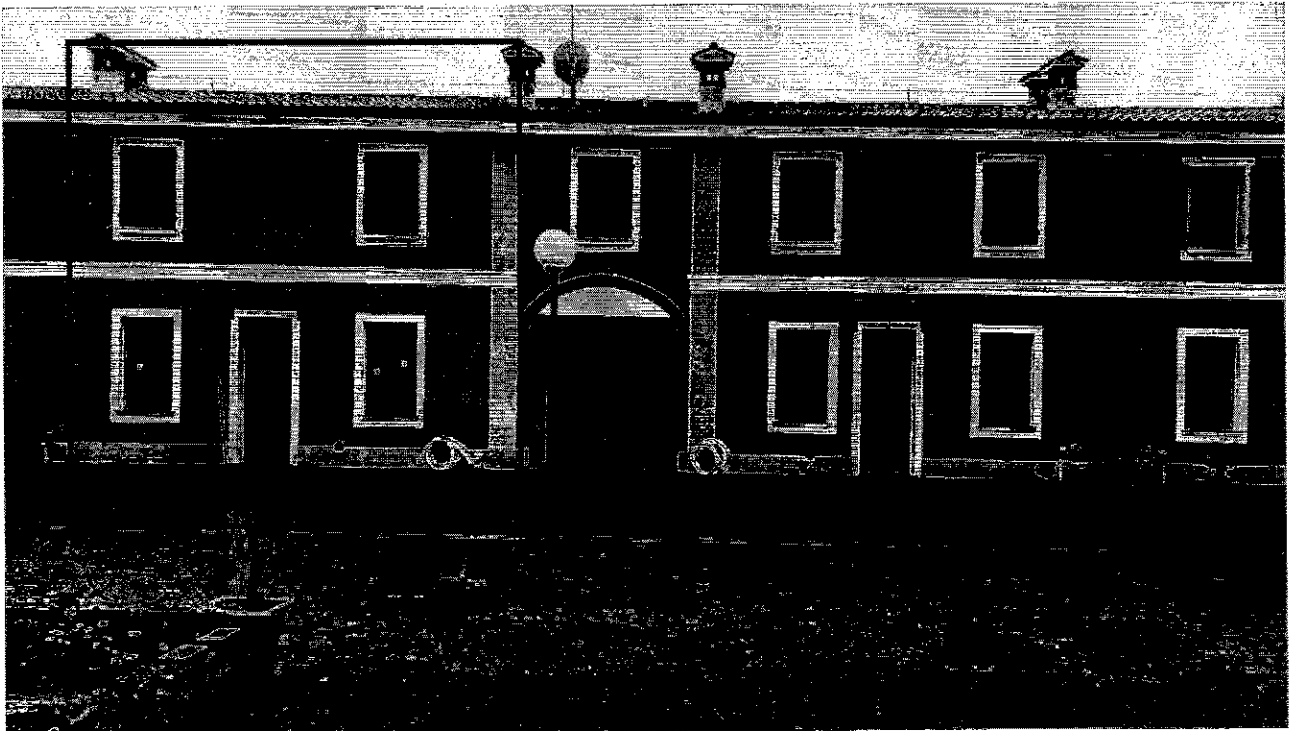
Vista dal cortile interno
