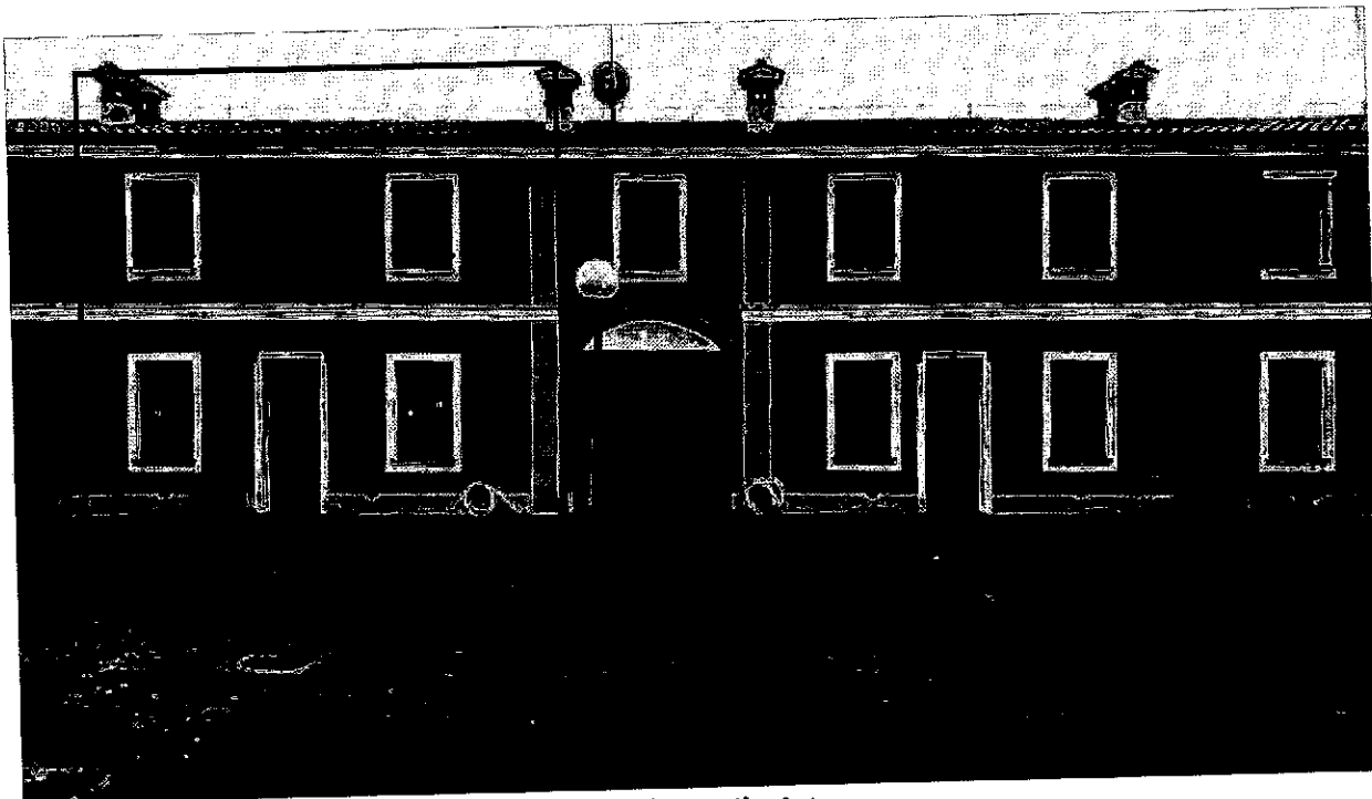
Vista dal cortile interno
