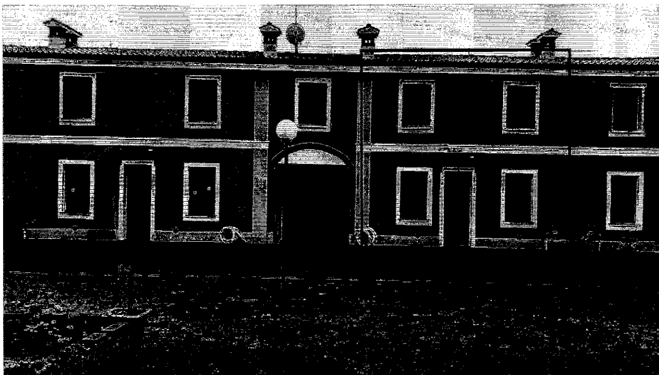
Vista dal cortile interno
