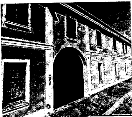
Particolare del portone e dei serramenti
