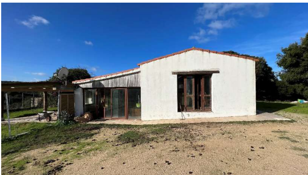
Figura 4 – Viste delle facciate esterne della casa colonica
