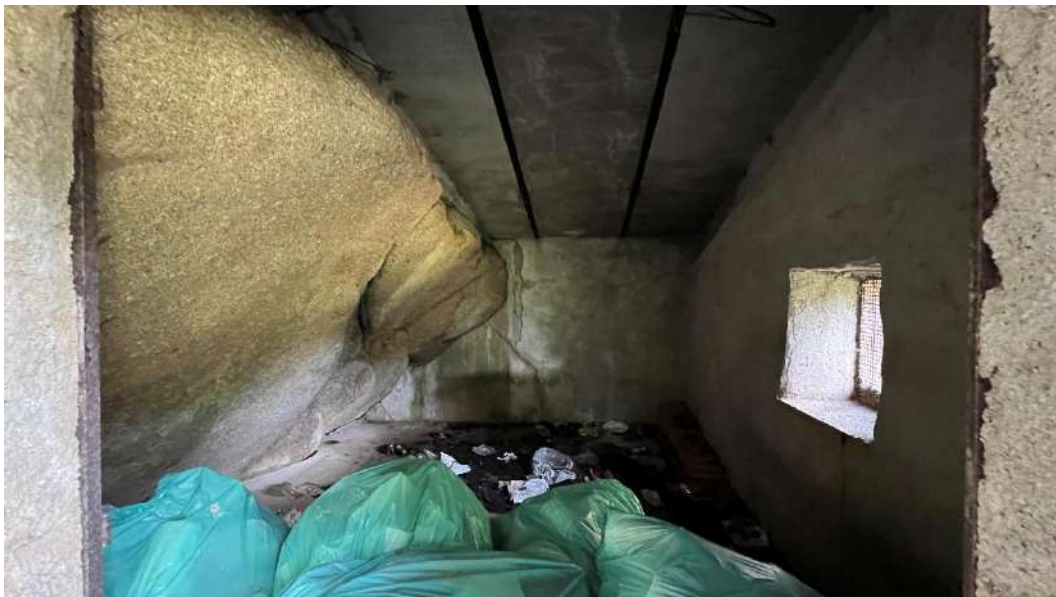
Figura 5 – Viste del deposito esterno
