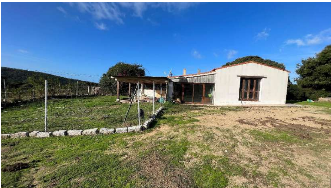
Figura 1 – Viste esterne del fabbricato
