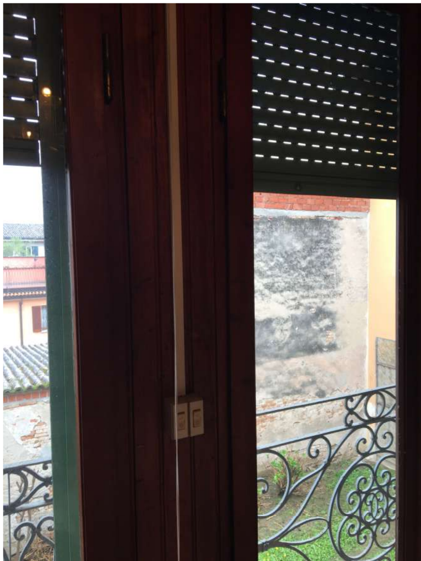
FOTO 18- PARTICOLARE INFISSI – P1°
