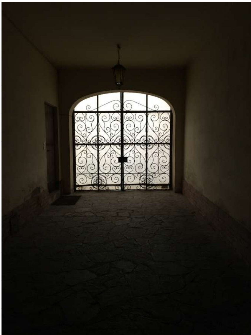
FOTO 2 – CANCELLO CARRAIO SU CORTILE INTERNO
