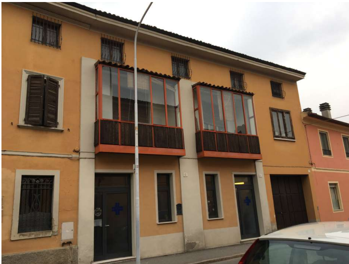
FOTO 1 – PROSPETTO SULLA VIA XI FEBBRAIO
