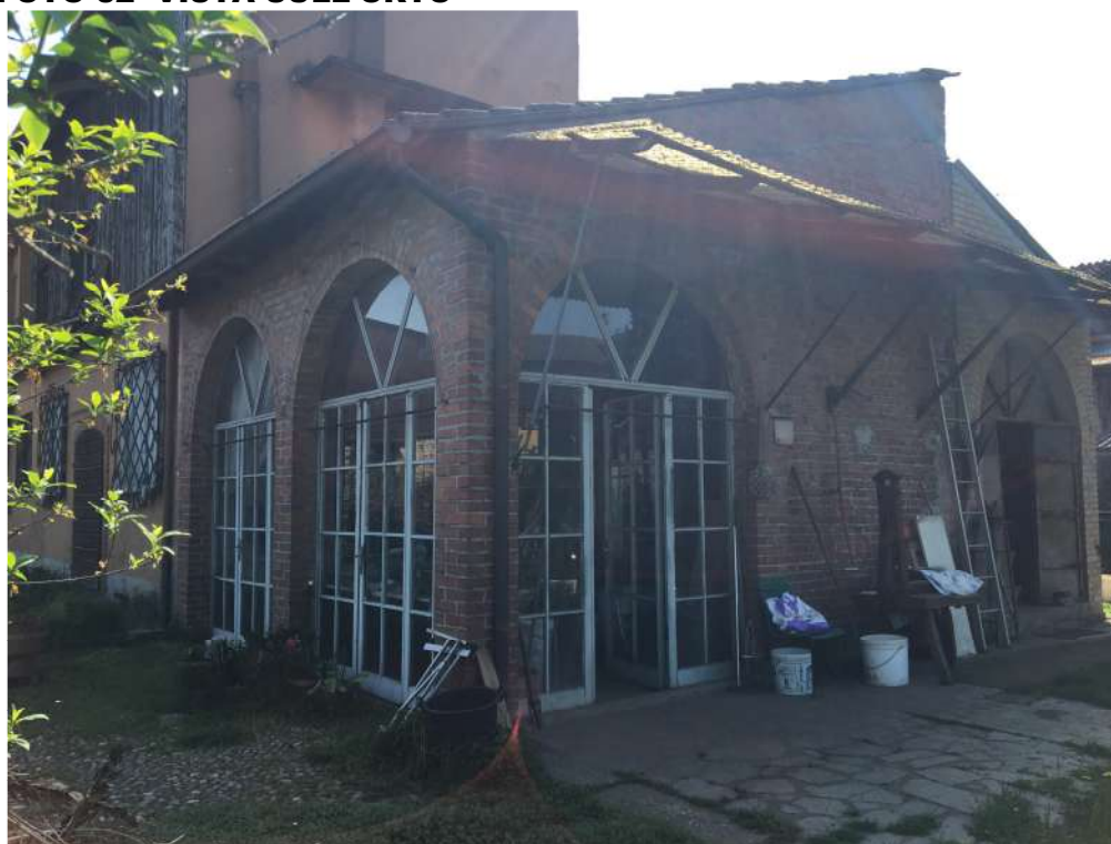
FOTO 33- VISTA SU FABBRICATO / DEPOSITO
